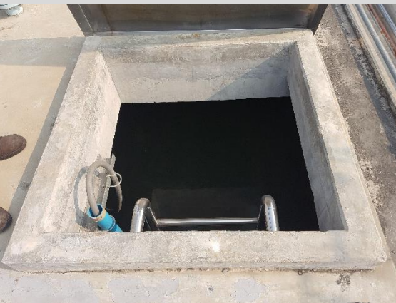
รูปที่ 2-8 ถังเก็บน้ำสำรองเพื่อการอุปโภค และน้ำสำรองดับเพลิง
