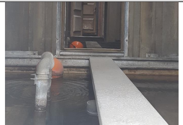
รูปที่ 2-8 ถังเก็บน้ำสำรองเพื่อการอุปโภค และน้ำสำรองดับเพลิง
