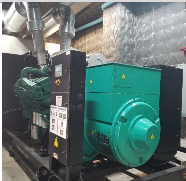
รูปที่ 2-10 หม้อแปลงไฟฟ้า และเครื่องกำเนิดไฟฟ้าสำรอง
