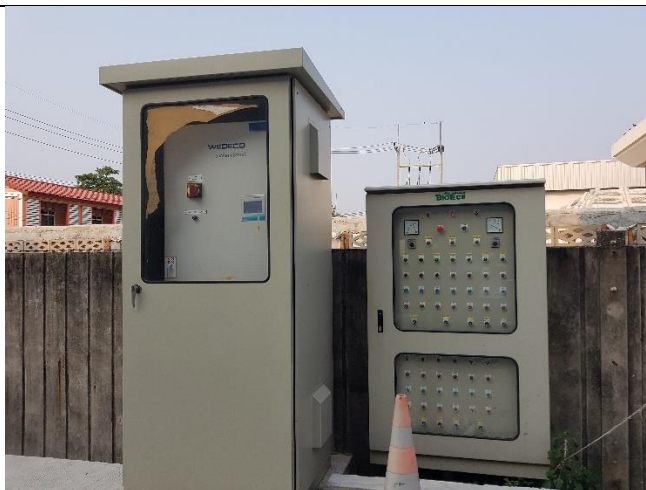
รูปที่ 2-18 การติดตั้งมาตรวัดไฟฟ้าของระบบบำบัดน้ำเสีย
