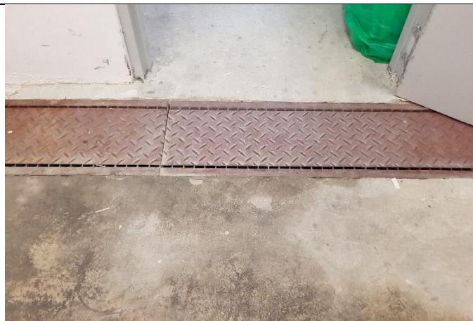
รูปที่ 2-12 รางรวบรวมน้ำเสียจากห้องพักรวมผู้ป่วยเข้าสู่ระบบบำบัดน้ำเสีย
